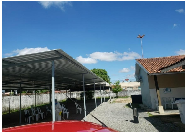
Imagem 16 – Cobertura para espera.
