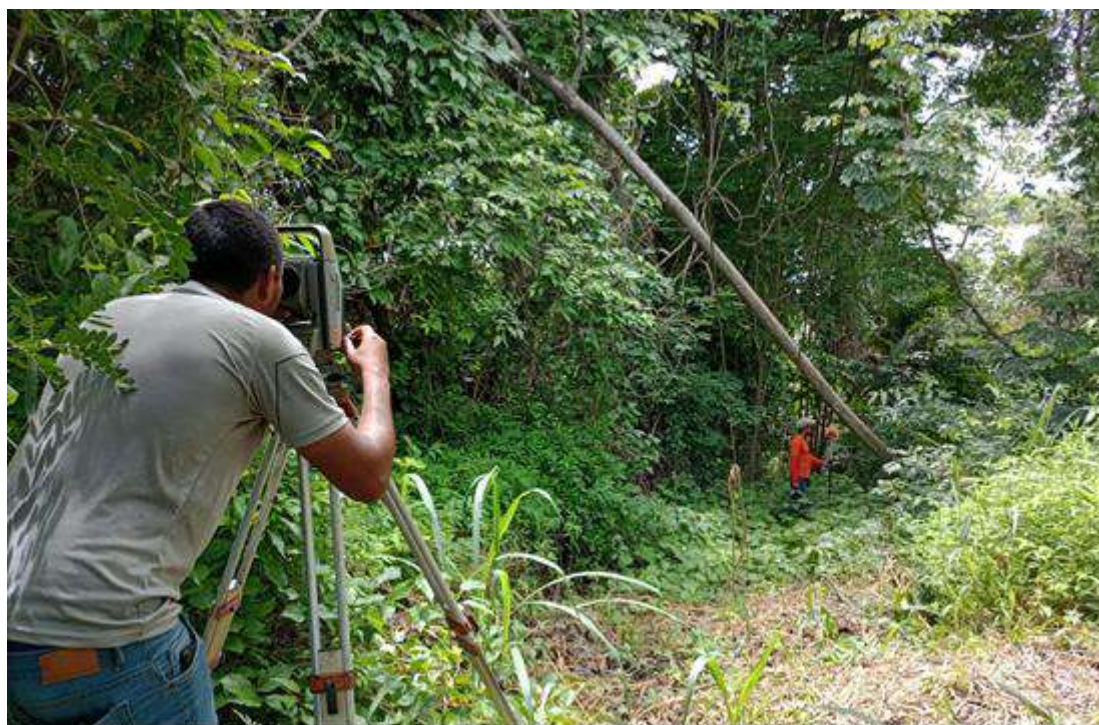
Levantamento por irradiação com estação total.
