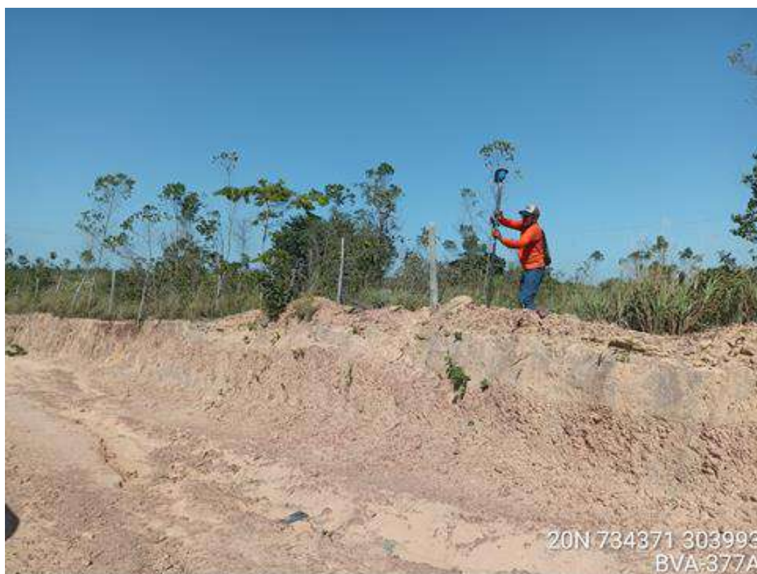
Levantamento planialtimétrico em “crista” de talude.
