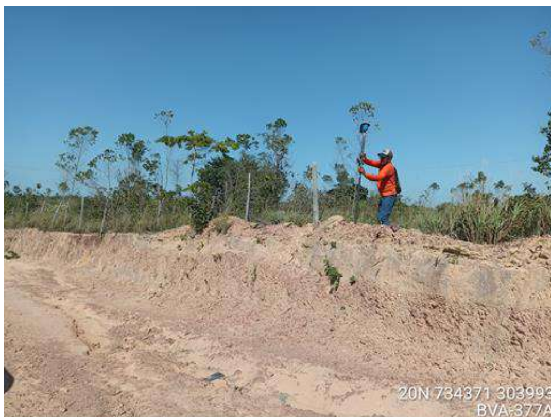
Levantamento planialtimétrico em “crista” de talude.
