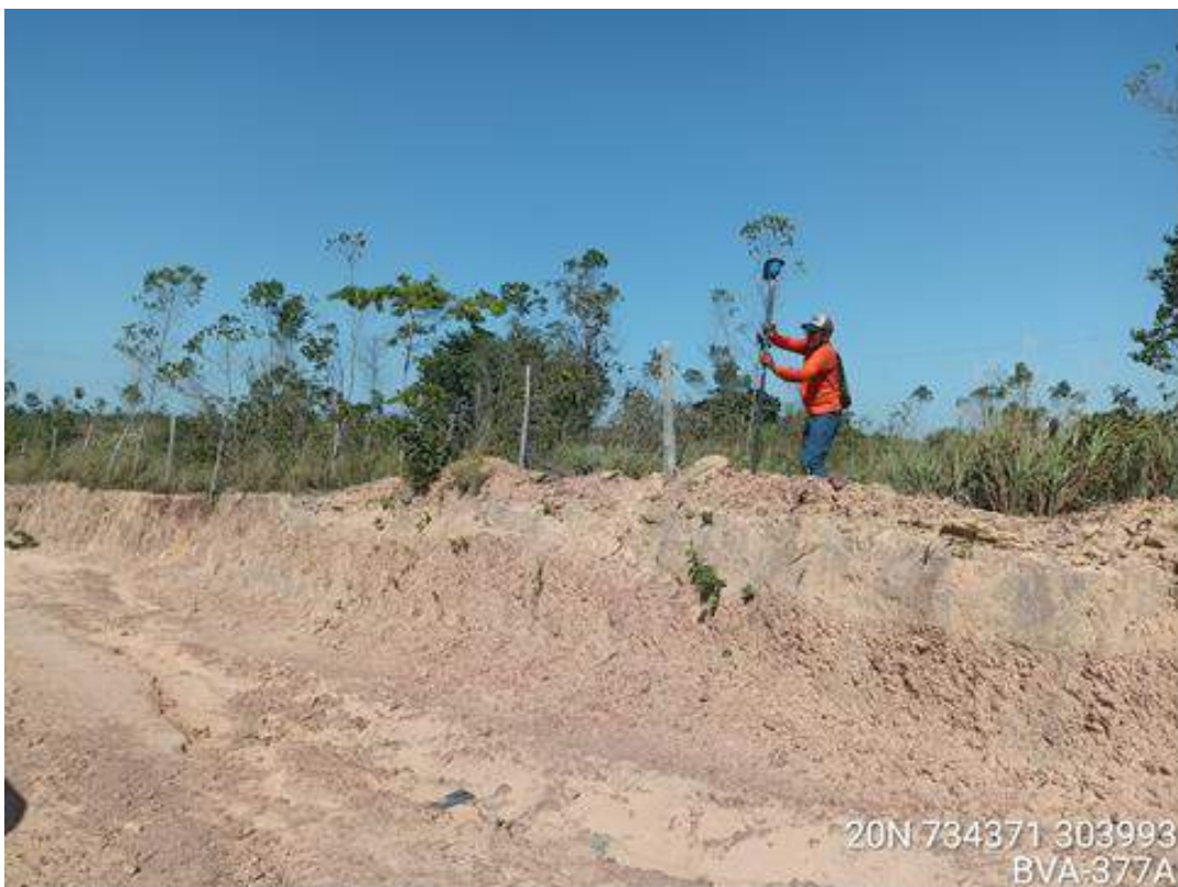
Levantamento planialtimétrico em “crista” de talude.
