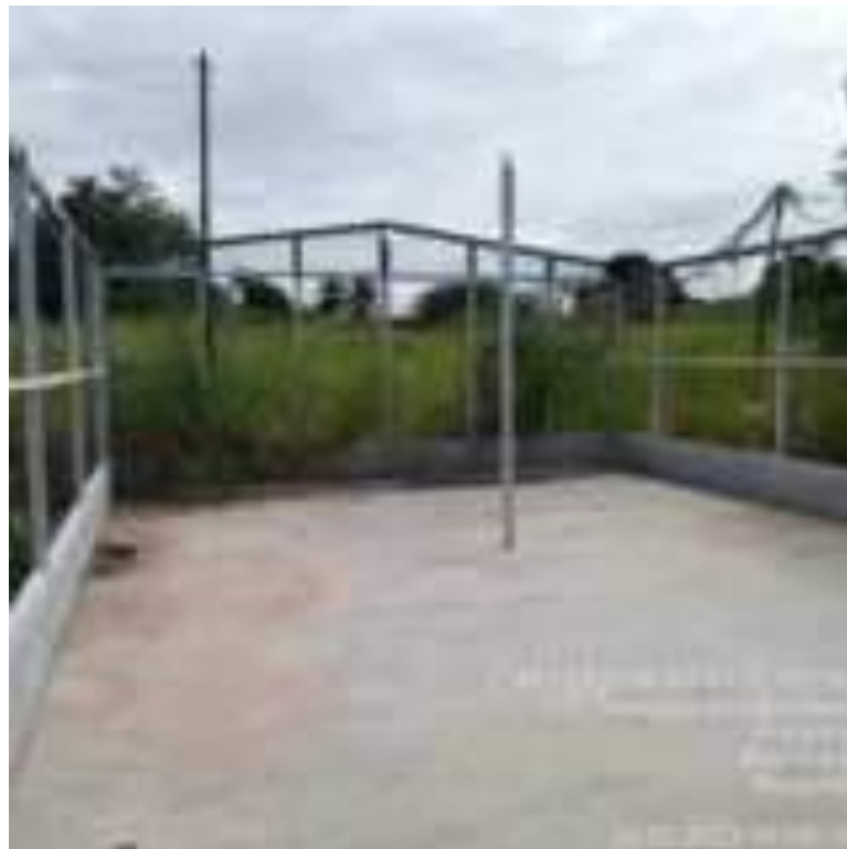
Imagem 8 – Refeitório do canteiro de obras existente (interno – 24.02.2023).
