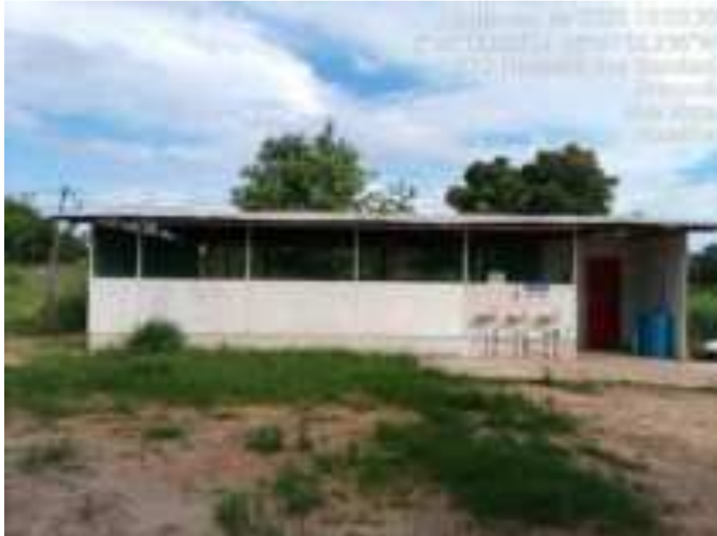
Imagem 5 – Refeitório do canteiro de obras existente (16.03.2022).
