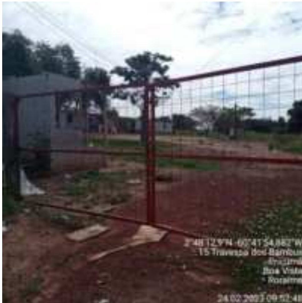
Imagem 2 - Porta de entrada do canteiro de obras existente (24.02.2023).
