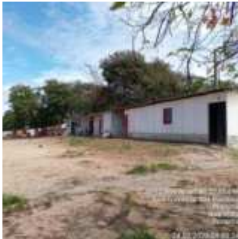
Imagem 4 – Escritório administrativo do canteiro de obras existente (24.02.2023).
