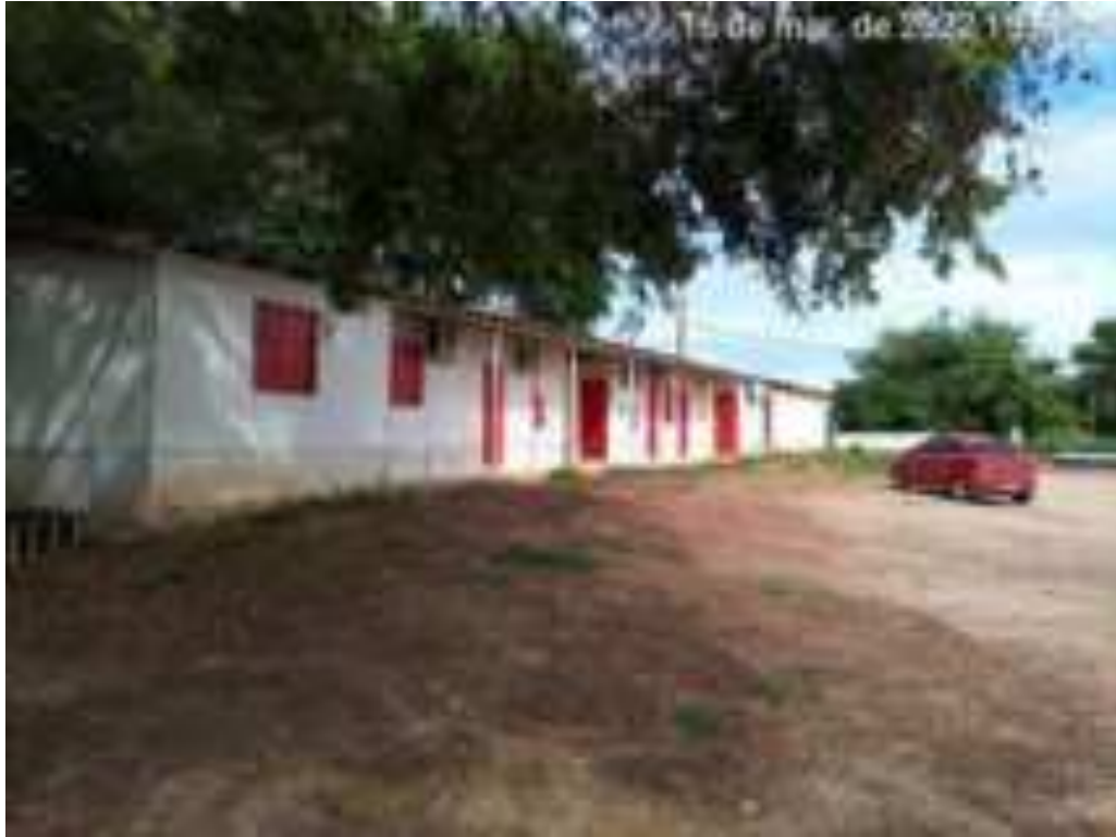
Imagem 3 – Escritório administrativo do canteiro de obras existente (16.03.2022).
