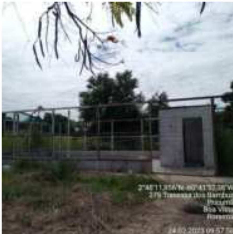
Imagem 6 – Refeitório do canteiro de obras existente (24.02.2023).
