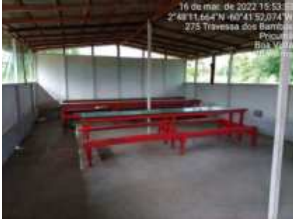
Imagem 7 – Refeitório do canteiro de obras existente (interno – 16.03.2022).
