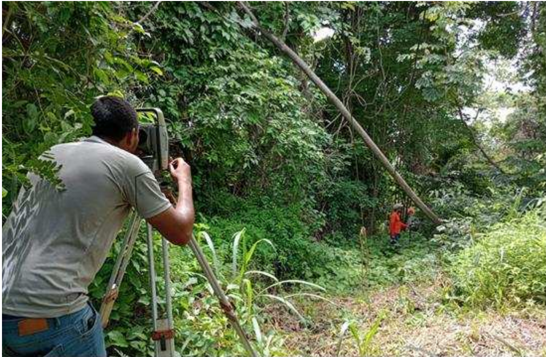
Levantamento por irradiação com estação total.
