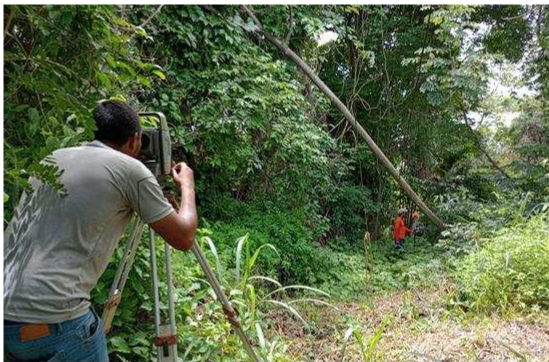
Levantamento por irradiação com estação total.
