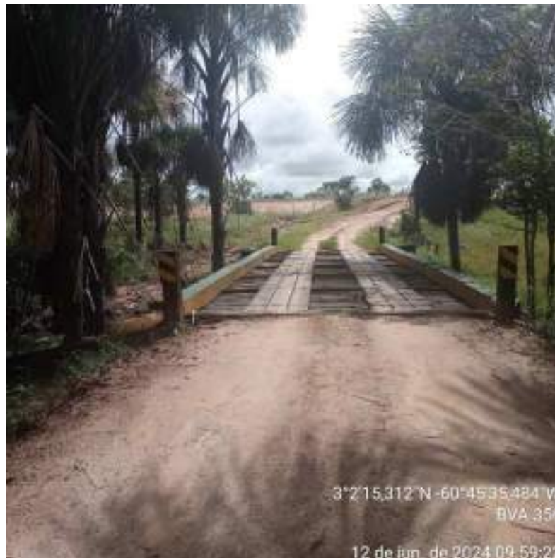
IMAGEM 10 – BVA 356 PONTE DE MADEIRA KM 2,7
