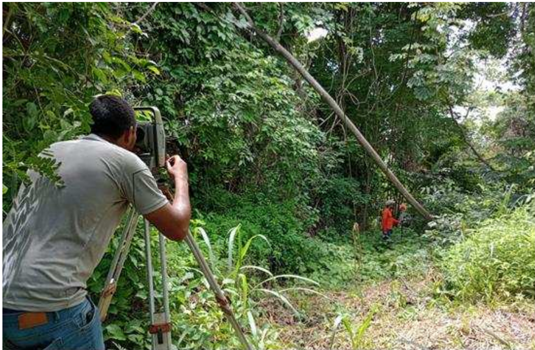
Levantamento por irradiação com estação total.
