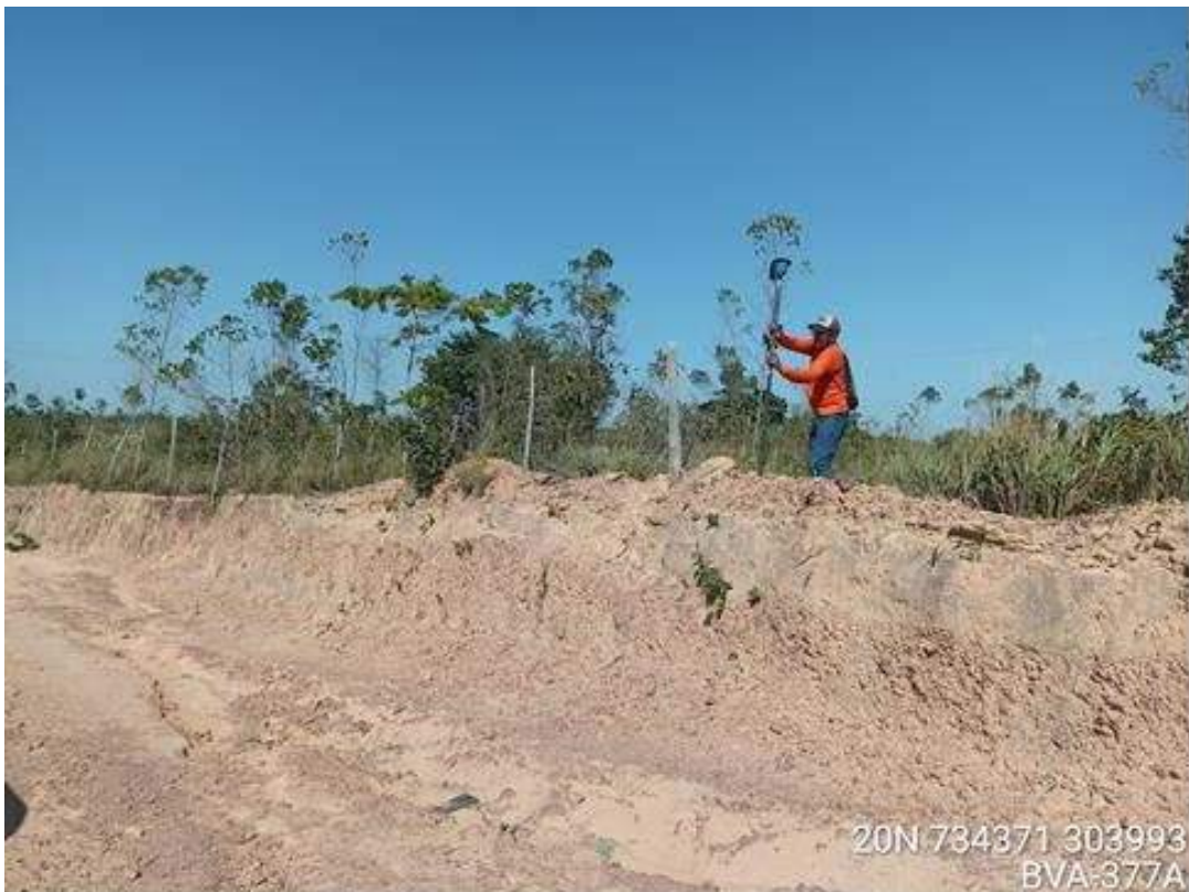
Levantamento planialtimétrico em “crista” de talude.
