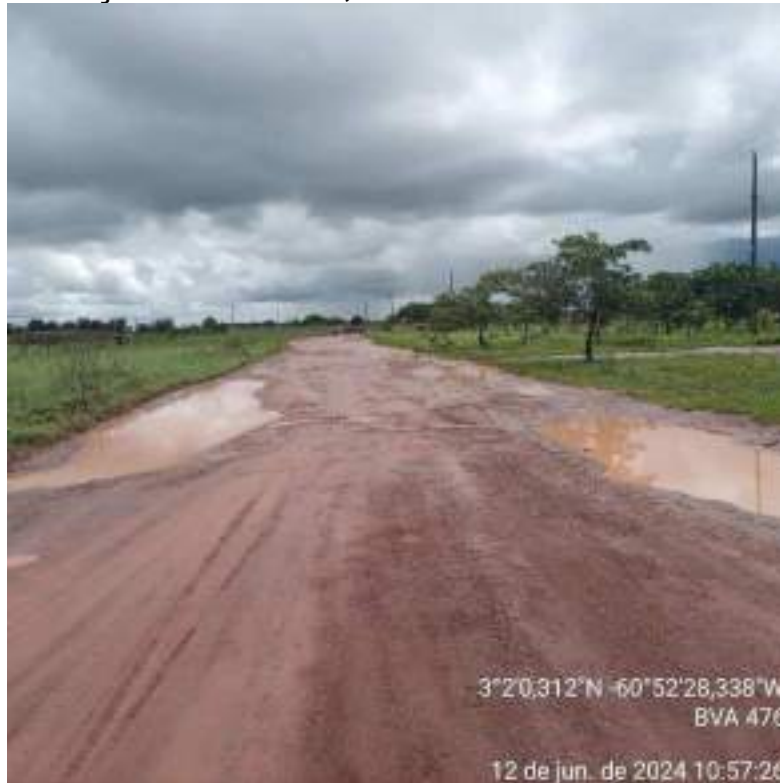
IMAGEM 15 – BVA 476 KM ACUMULO D' ÁGUA KM 5,5
