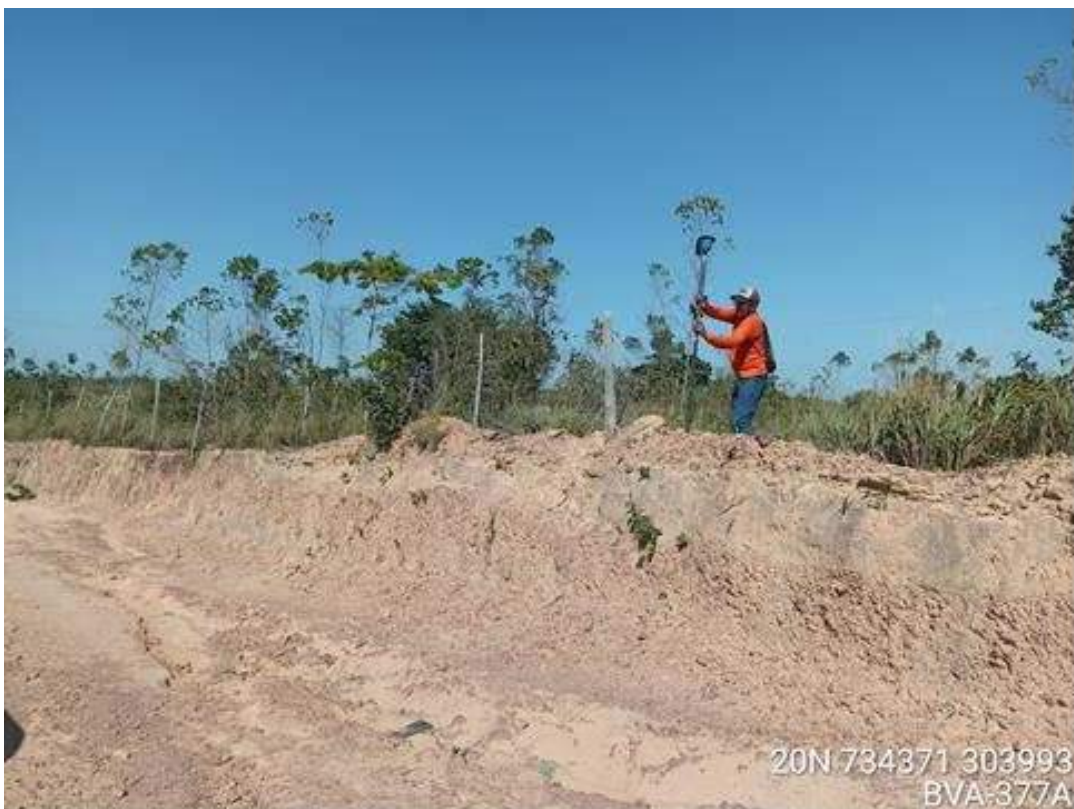
Levantamento planialtimétrico em “crista” de talude.
