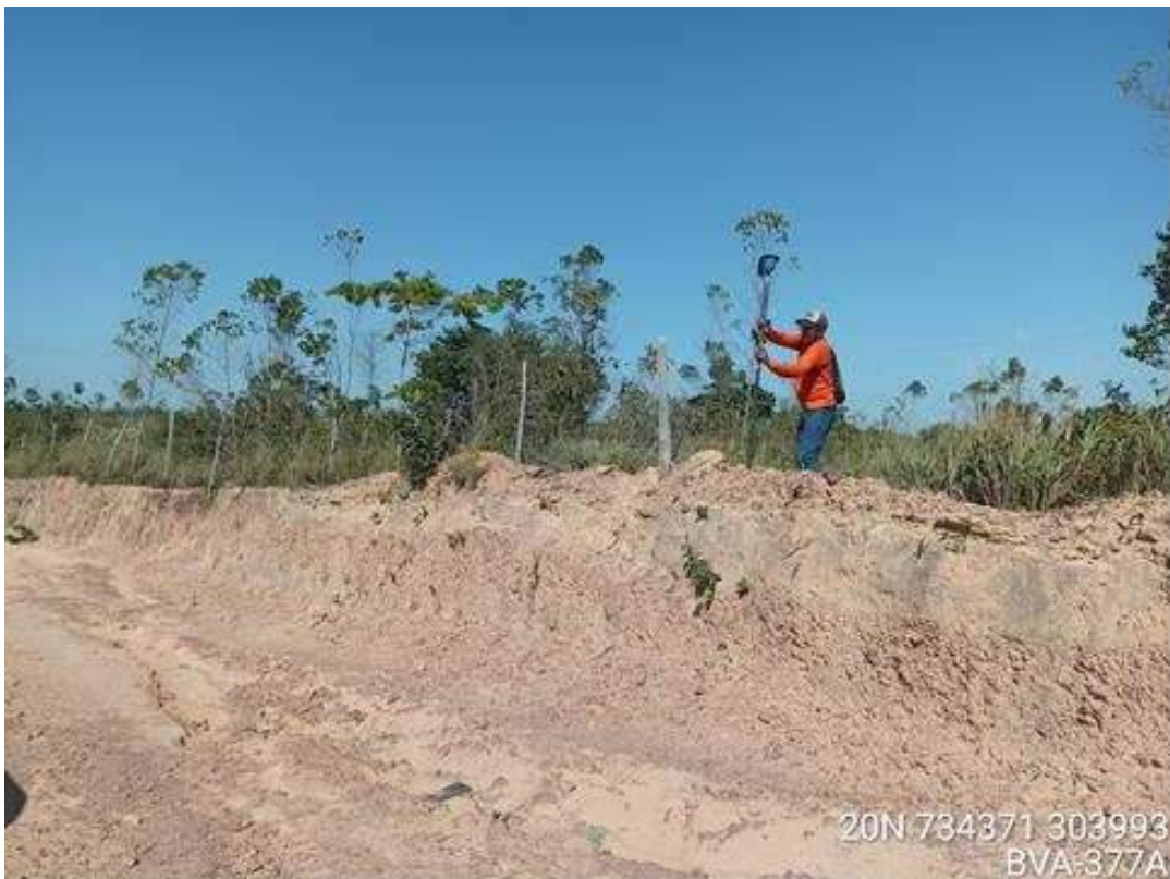
Levantamento planialtimétrico em “crista” de talude.
