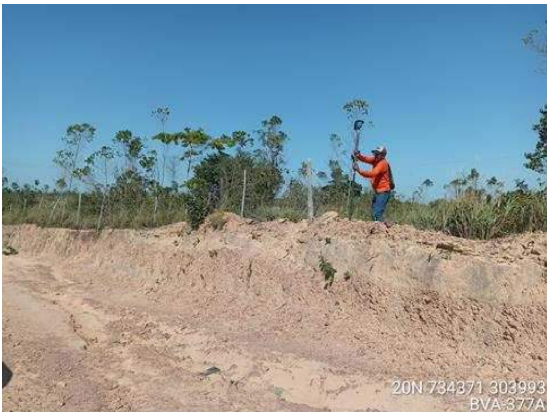
Levantamento planialtimétrico em “crista” de talude.
