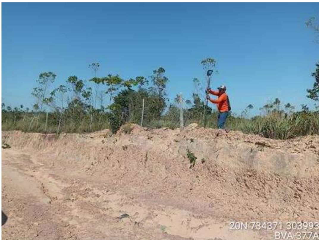
Levantamento planialtimétrico em “crista” de talude.
