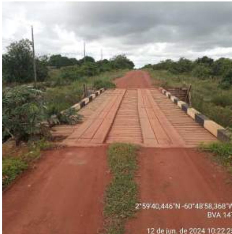
IMAGEM 06 – BVA 147 PONTE DE MADEIRA DEPOIS DO KM 02
