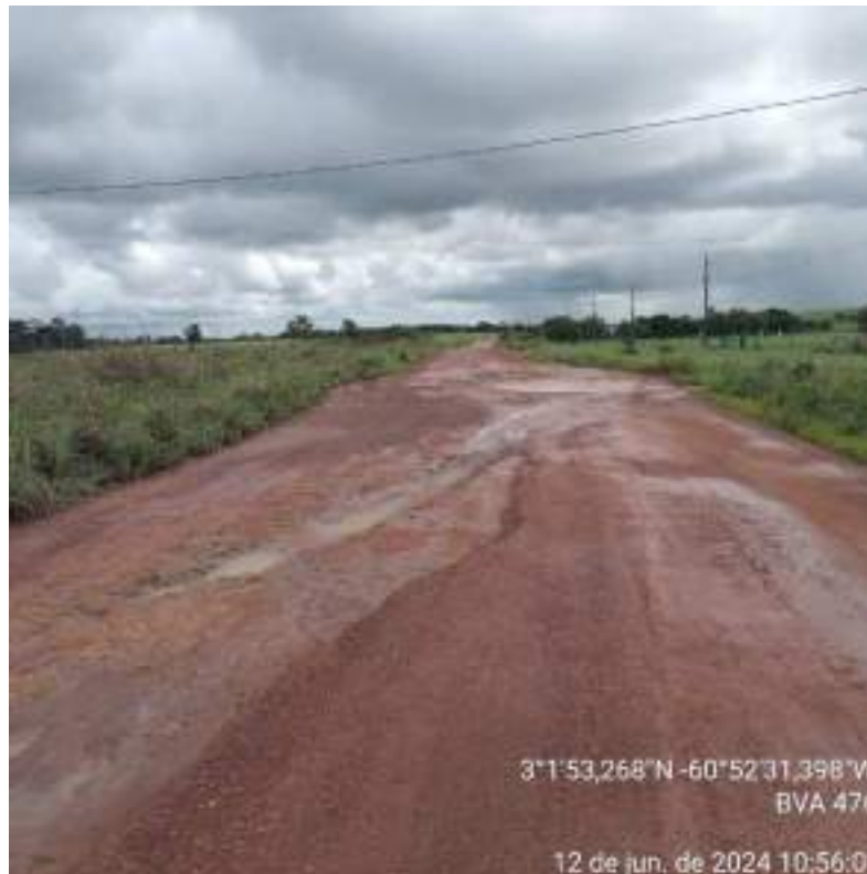
IMAGEM 14 – BVA 476 KM ACUMULO D" ÁGUA KM 5,2
