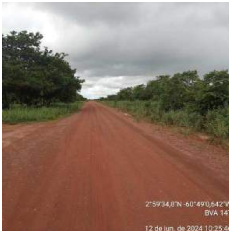
IMAGEM 08 – FINAL TRECHO BVA 147 KM 2,65
